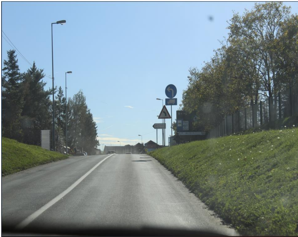
Slika 6: Pogled na magistralnu cestu M 14.1 od nadvožnjaka prema raskrsnici za skretanje u JP "Luka Brčko"
