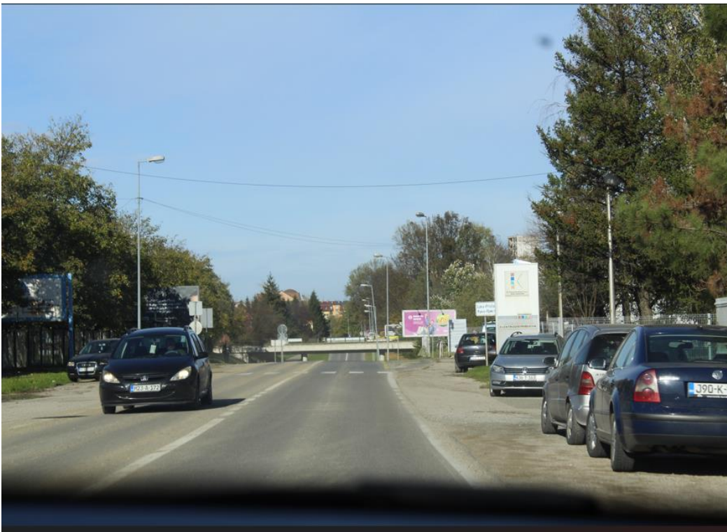
Slika 8: Pogled na magistralnu cestu M14.1 od kružnog toka prema nadvožnjaku
