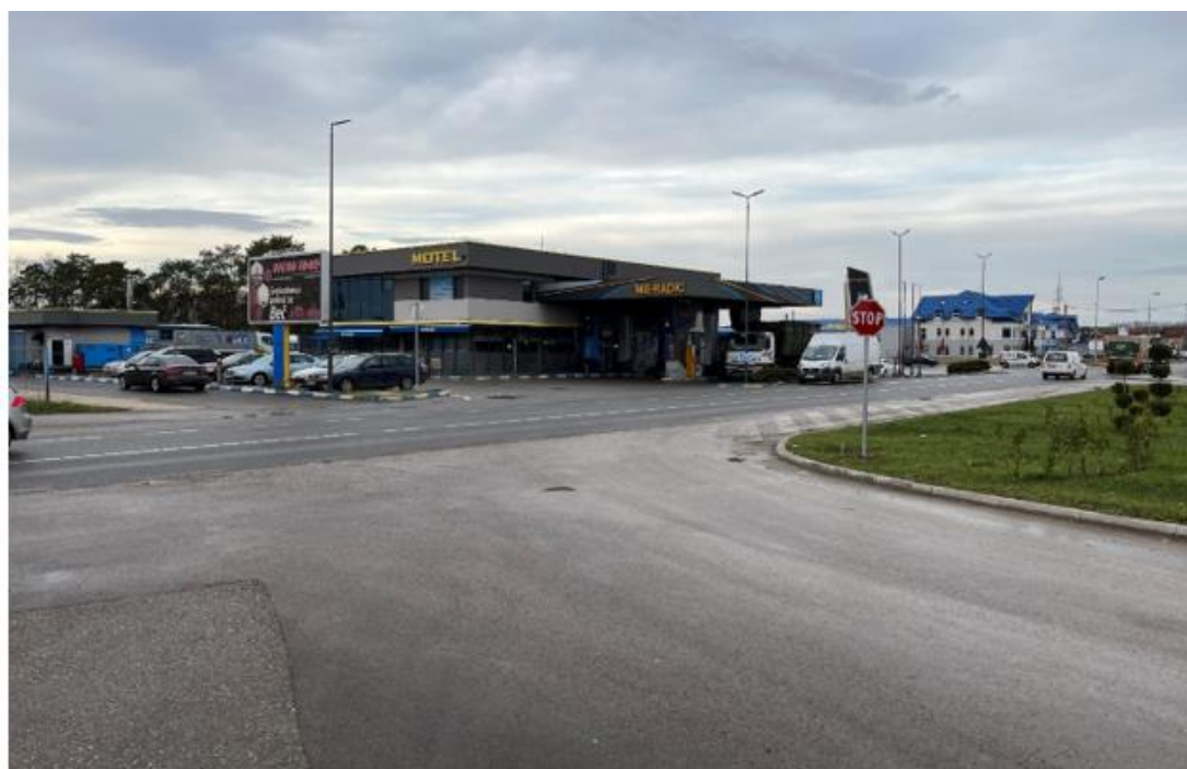
Slika 31: Pristup magistralnoj cesti M14.1 sa gradske deponije
